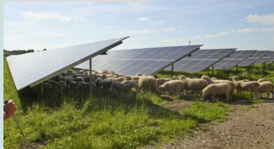
Foto: eksempel på solceller på faste stativer
